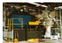
木くずボイラー
