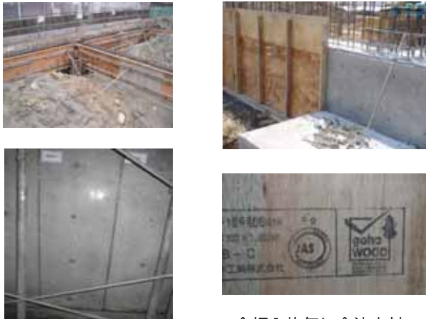
国産材型枠用合板の打設面
