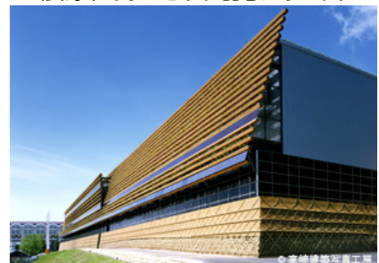
運営施設：内外装木材利用の仮設建築 (洞爺湖サミット国際メディアセンター)
