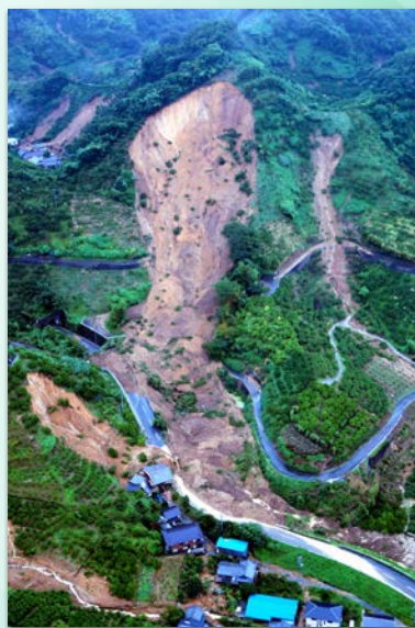
愛媛県、各地で土砂崩れ・氾濫
