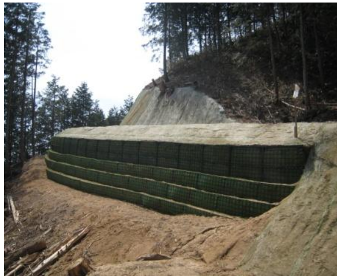
鋼製土留工の施工事例(京都府)
