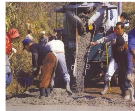
容易な施工(人力施工)
