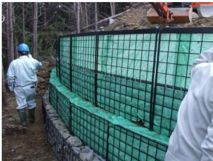
鋼製土留工の施工事例(京都府)
