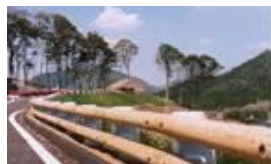
ガードレール
