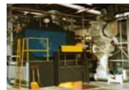
木くずボイラー
