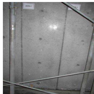
国産材型枠用合板の打設面
