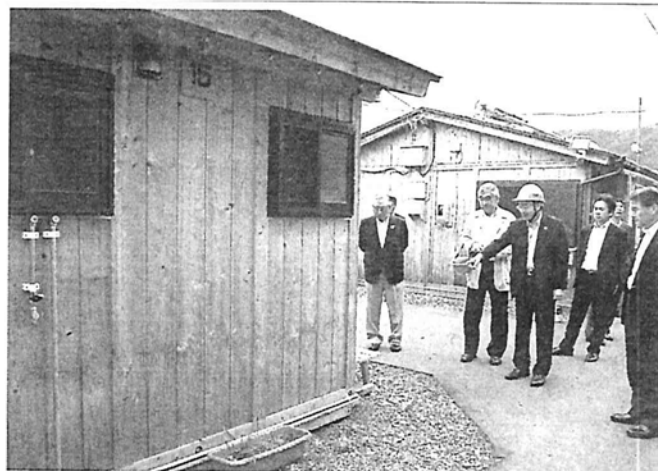
町独自で建設した木造仮設住宅を視察＝住田町
