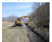
農業用排水路 補修作業
