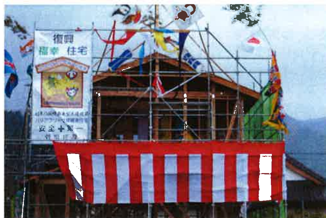
復興住宅第1号の上棟式
