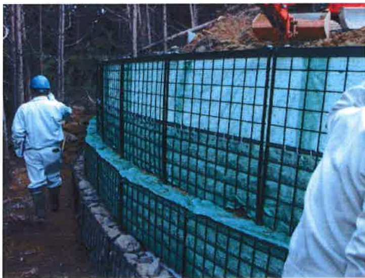
鋼製土留工の施工事例(京都府)
