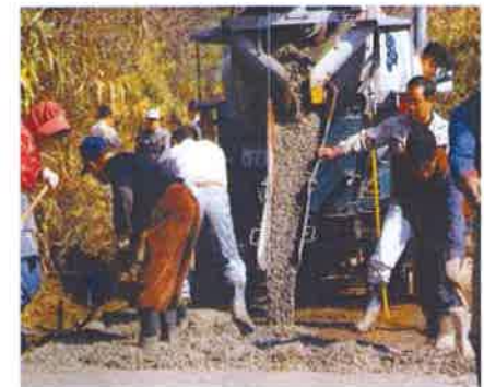
容易な施工(人力施工)
