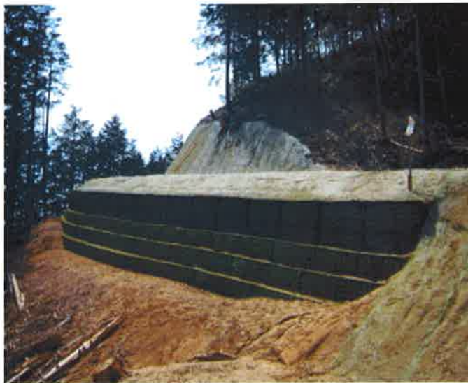
鋼製土留工の施工事例(京都府)
