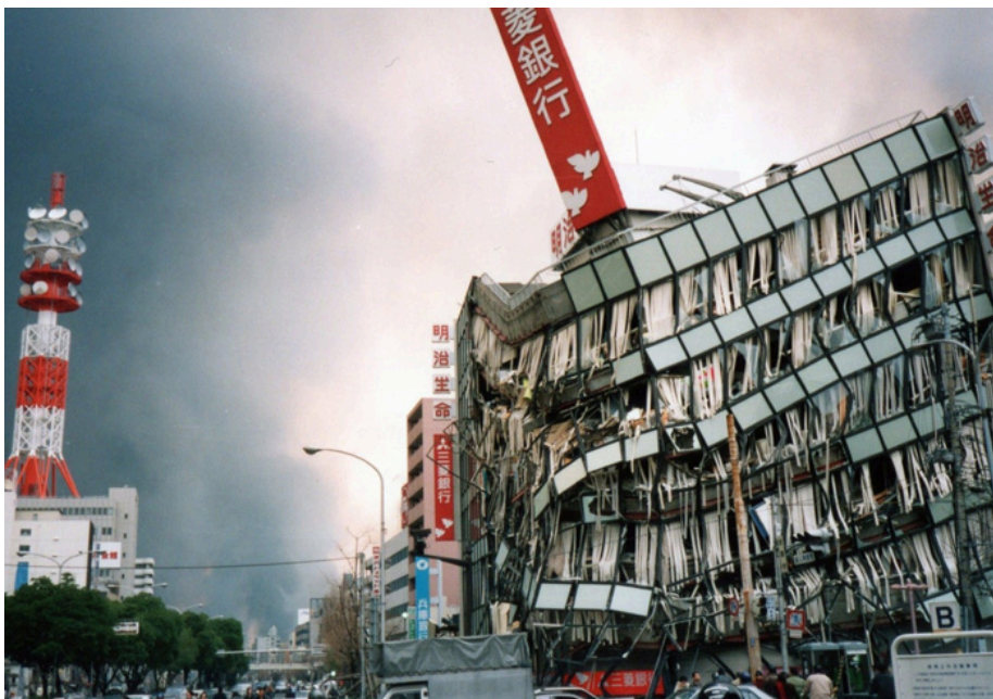
1995年1月の神戸市兵庫区の様子。ビルが大きく損壊している（詳しい撮影日は不明）（神戸市提供、「阪神・淡路大震災『1.17の記録』」から）
