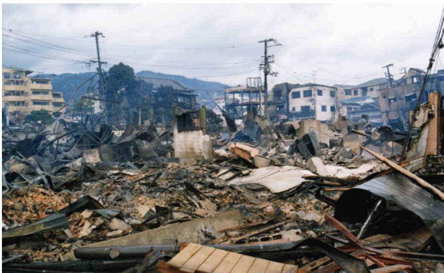
1995年1月19日の神戸市灘区の様子。多くの住宅が全壊している (神戸市提供、「阪神・淡路大震災『1.17の記録』」から)
